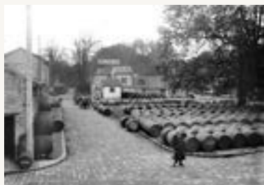
Entrepôts de vins de Bercy. Le carrefour de la rue du Petit-Château et de la rue du port de Bercy. Paris. © Albert Harlingue / Roger-Viollet
